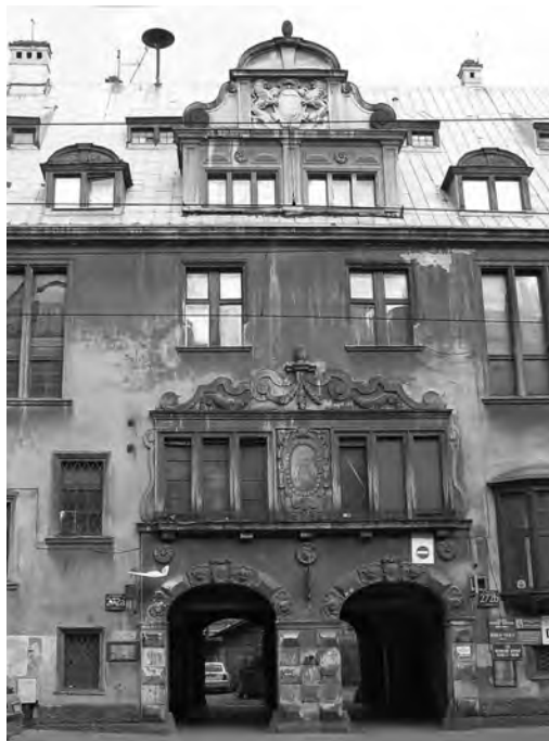
13. Łódź, pałac braci Steinertów przy ul. Piotrkowskiej 272a-b – część środkowa fasady; fot. K. Stefański.
