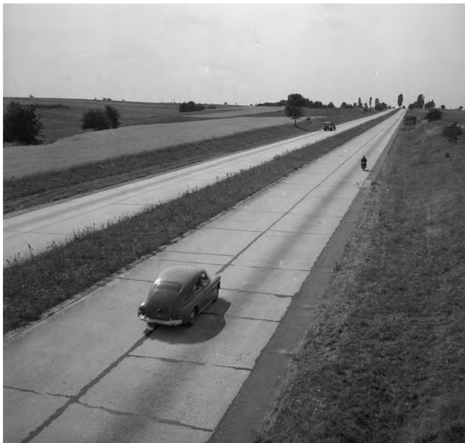
12. Autostrada Wrocław–Zgorzelec, 1969 r.
