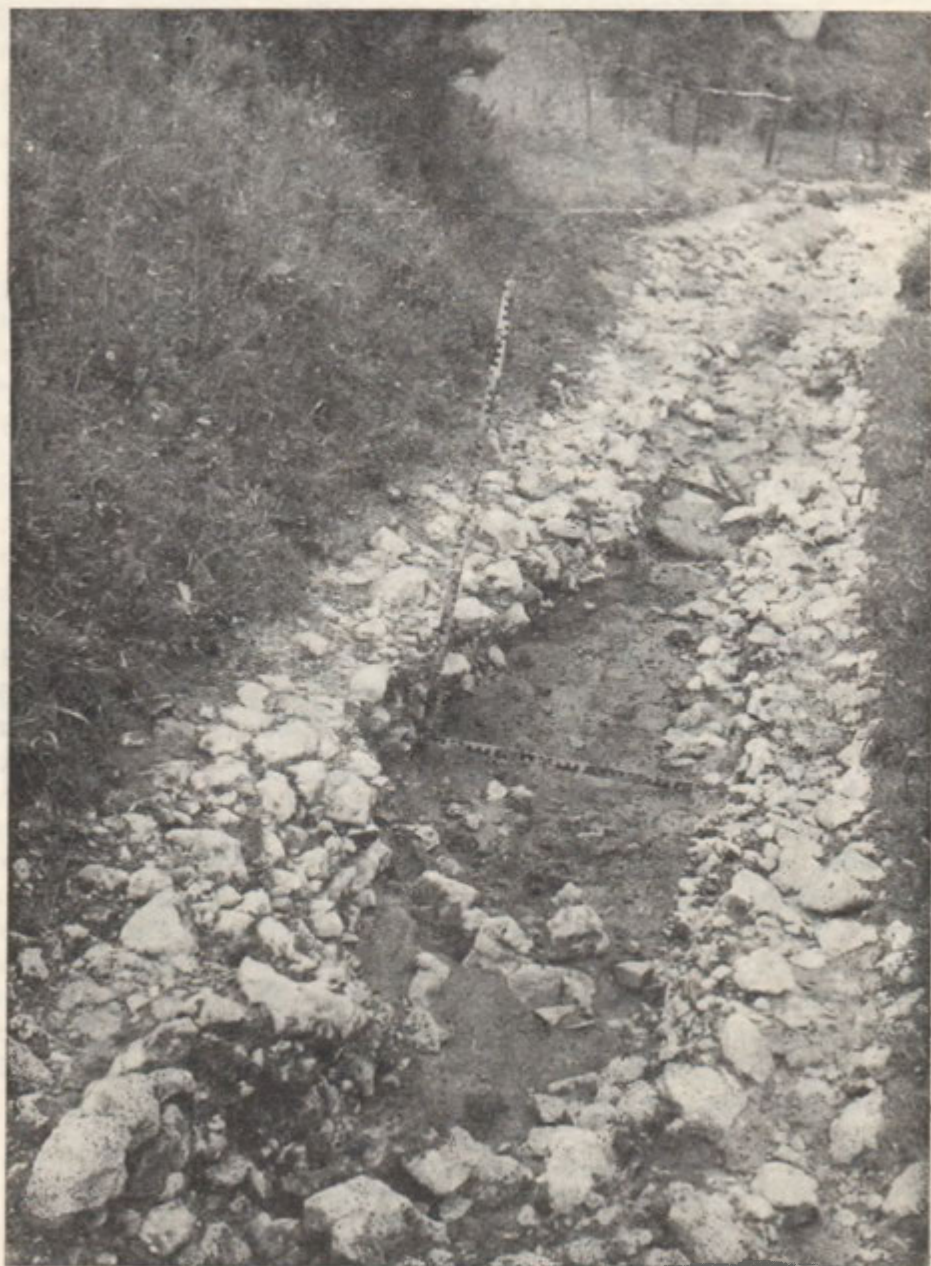
Fot. 9. Rozcięcie erozyjne drogi polnej
