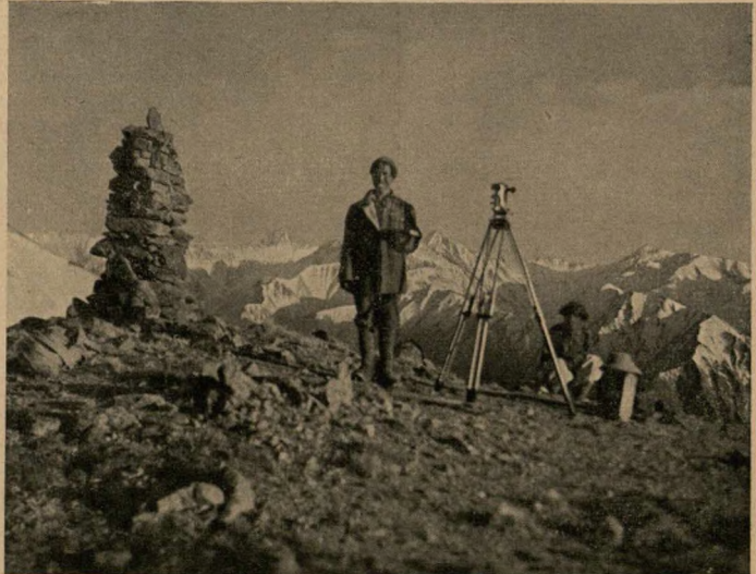
Abb. 5. Triangulation mit Theodolit Zeiss II am Steinmann „Astor Ost“.
