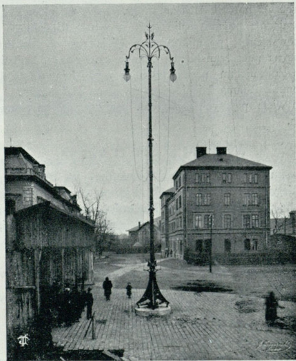
Masz 14-to metrowy przed bud. nowego Dworca we Lwowie. — Wykonano w fabryce J. Góreckiego w Krakowie.
