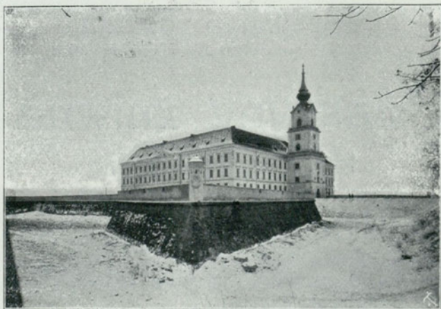
Rzeszów — Sąd obwodowy dawniej zamek ks. Lubomirskich.
