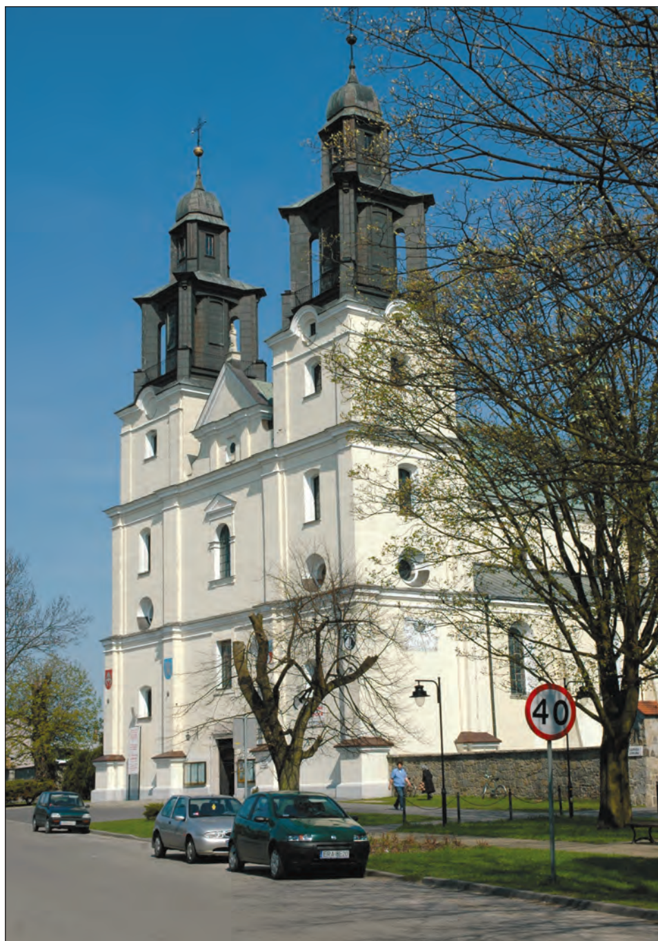
Ryc. 6. Gidle, kościół dominikanów, fasada. Stan obecny. Fot. P. Dettloff
