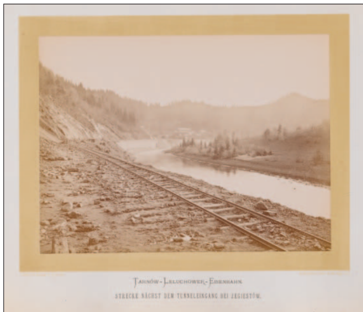
Ryc. 2. Tory w pobliżu wjazdu do tunelu pod Żegiestowem (z albumu Kolei Tarnów–Leluchów), fot. Awit Szubert, ok. 1876 (Muzeum Krakowa, nr inw. MHK-Fs16552/IX)
