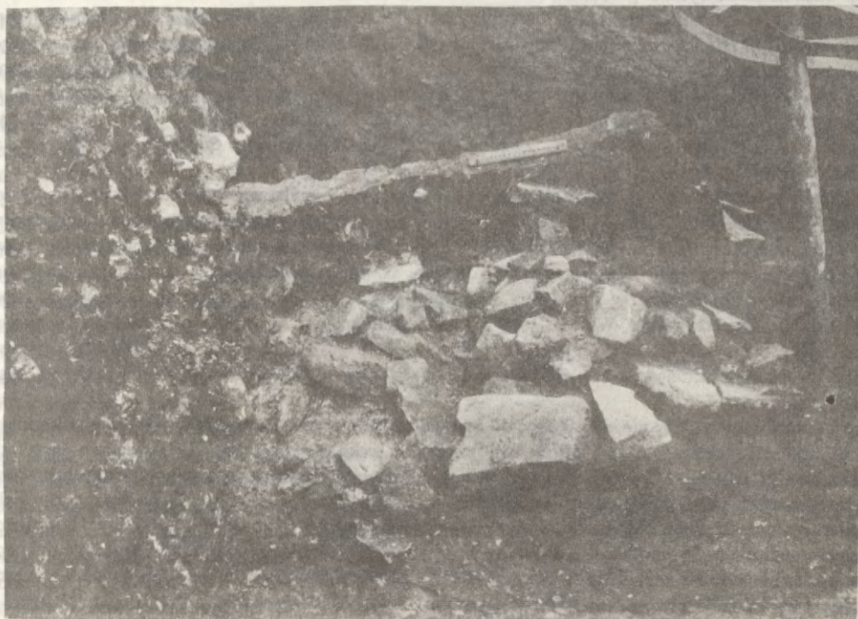
Ryc. 3. Kraków — Wawel, północno-zachodnia krawędź wzgórza, ár 321/C. Resztki muru płytkowego (przedromańskiego) odsłonięte w wykopie instalacji energetycznej WZ-3. Widok od E
