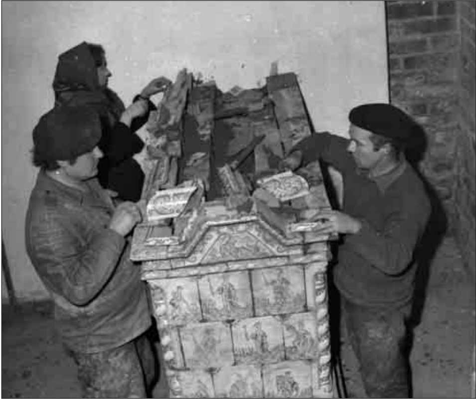
Ryc. 2. Maria Dąbrowska ze zdunami podczas prac nad rekonstrukcją pieca z 1737 r. przeniesionego z pałacu w Karkajmach do Fromborka, 1977 r. (fot. z archiwum Muzeum Mikołaja Kopernika we Fromborku)
