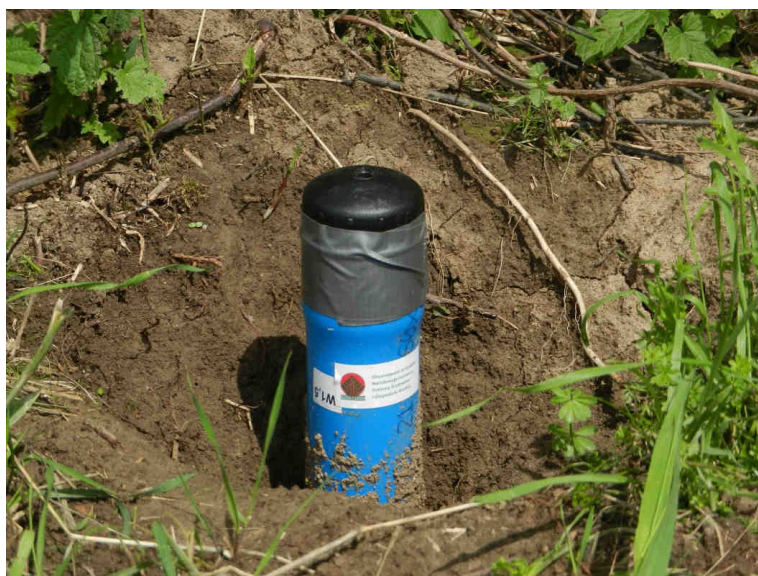
Ryc. 9. Piezometr zainstalowany na łące obok powierzchni badawczej w Białobrzegach (fot. A. Kowalska)
