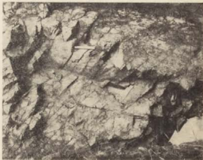
Ryc. 15. Jańska Góra. Strefa eksploatacyjna w obrębie szybu 2. Z prawej widoczne głębokie wyrębisko otoczone negatywami po wydobytych blokach, z lewej próg o naturalnym stropie oddzielającego szyb 2 od szybu 1. Widok od zachodu. Fot. R. Sierka
