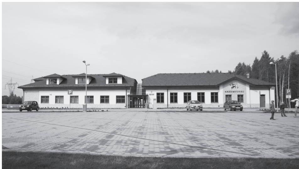
Ryc. 1. Krzemionki, pow. ostrowiecki. Nowe budynki wzniesione w celu obsługi ruchu turystycznego i na siedzibę muzeum archeologicznego, oddane do użytku w 2012 r.
