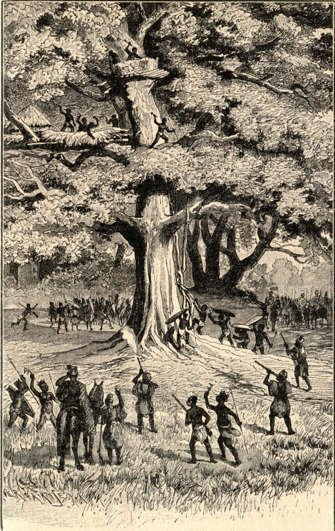
Figur 17. Befestigungsanlage in den Zweigen eines Baumes.
