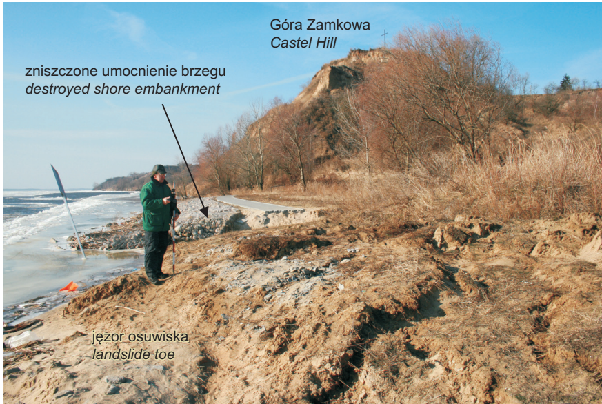
Fot. 2. Czoło osuwiska centralnego. W centralnej części widoczna zniszczona zabudowa brzegu, w tle Góra Zamkowa. 16 lutego 2011 r.
