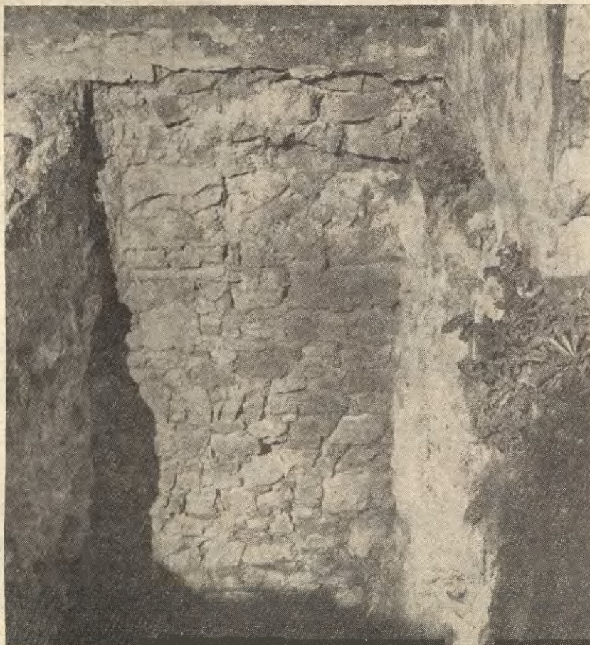
Ryc. 2. Wieliczka, pow. Kraków. Zamek. Lico muru kamiennego z fragmentem obramowania okiennego, odkryte w fundamentach wschodniej ściany budowli mieszkalnej położonej centralnie w obrębie murów
