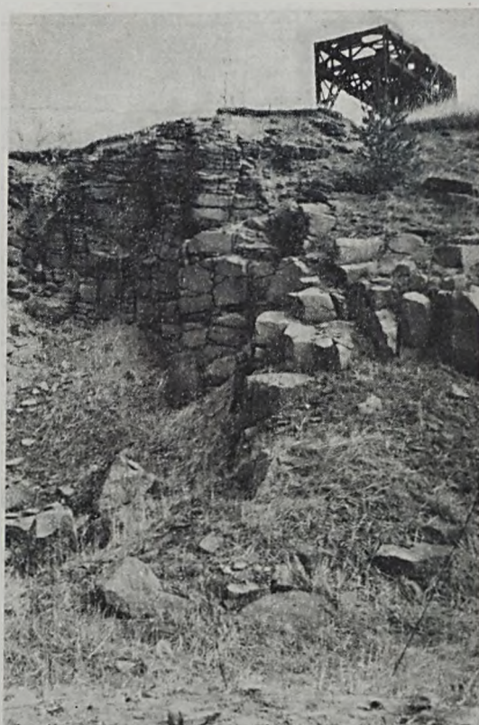
Ryc. 5. Płytkowa oddzielność kolumn pokrywy lawowej nefelinitu pod wpływem wietrzenia. Kamieniołom Księginki koło Lubania, górny poziom eksploacyjny, w części pn.-wsch.
