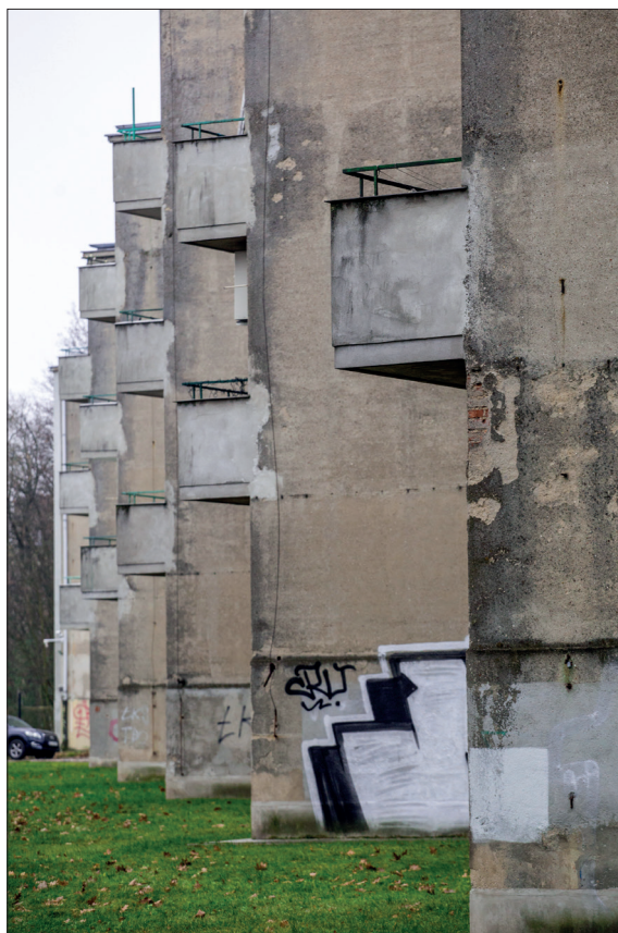
Fot. 2. Blok przy al. Unii Lubelskiej 18 (widok od strony północnej pokazujący surowość i kanciastość architektury osiedla), grudzień 2021. Fot. Sebastian Nowakowski.
