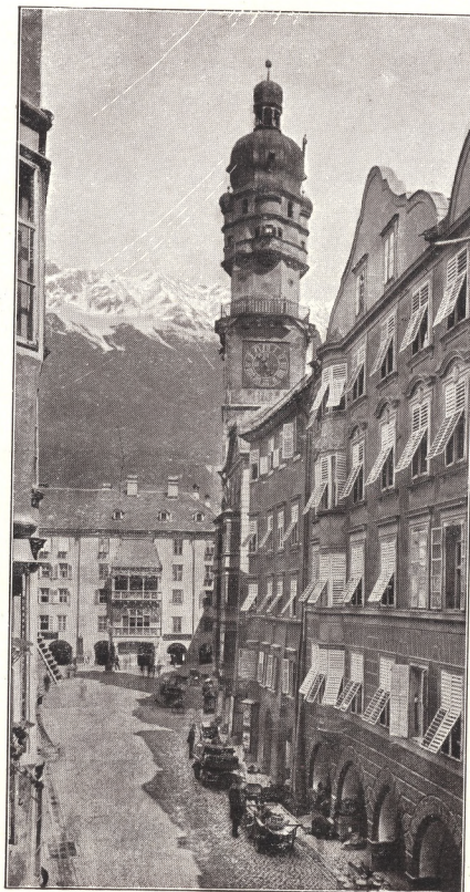
Herzog Friedrichstraße, mit Gold. Dachl.
