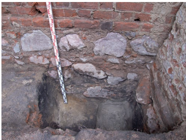
Ryc. 17. Kruszwica, stan. 2. Wykop sondażowy w południowo-wschodnim narożniku piwnicy 1 „kamienicy” zamkowej. Fot. P. Pawlak
