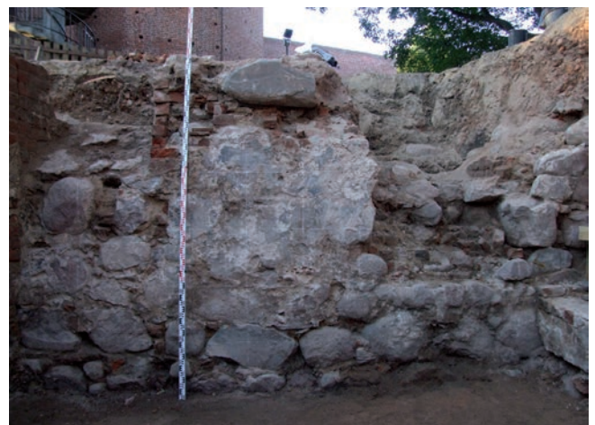
Ryc. 14. Kruszwica, stan. 2. Zachowane dwa otwory okienne, jeden z nich (zachodni) z ceglany wykończeniem gładów w północnej ścianie piwnicy 1 „kamienicy” zamkowej oraz pozostałości tynku z ciemnoszarą monochromią. Fot. P. Pawlak
