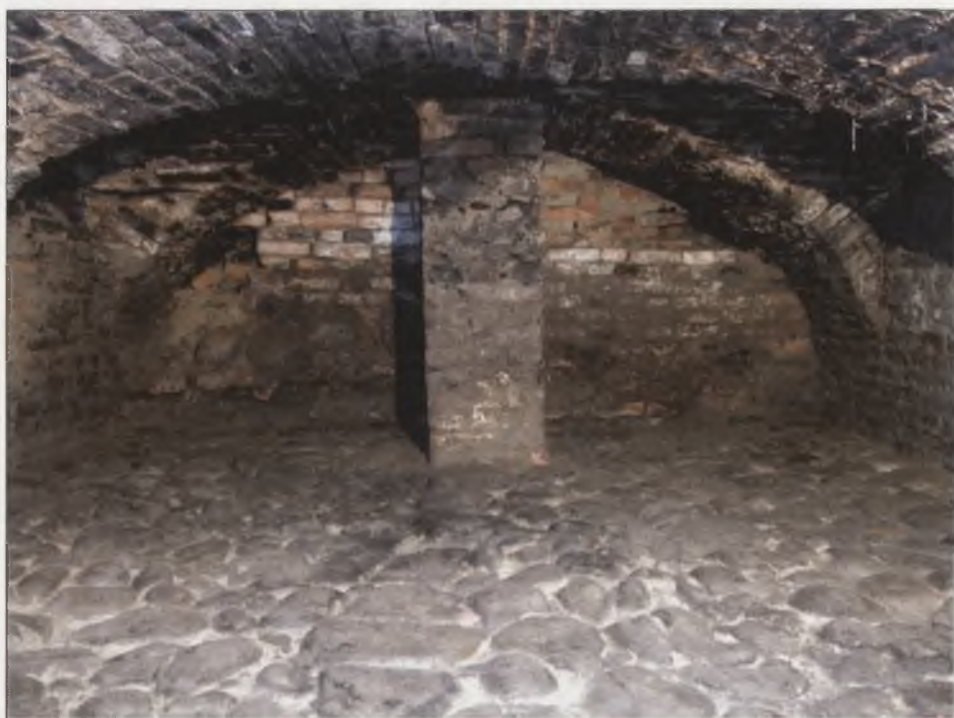
Ryc. 7. Wnętrze zachodniej komory paleniskowej pieca łaźiebnego. Fot. W. Bis
