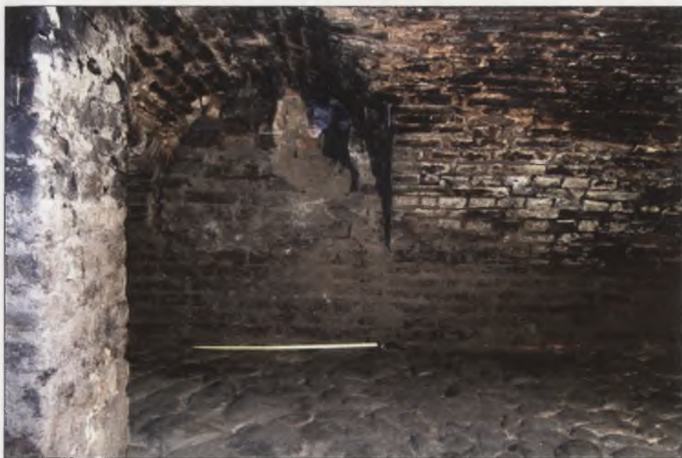
Ryc. 8. Wnętrze wschodniej komory paleniskowej pieca łaźniewego. Fot. W. Bis
