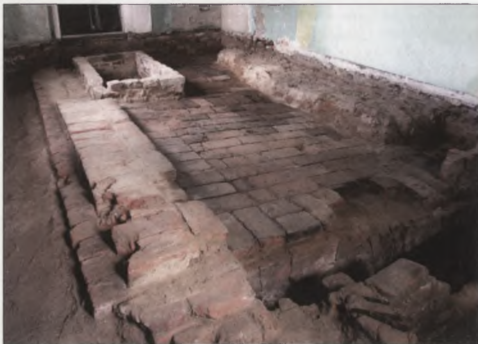
Ryc. 5. Posadzka ceglana nad zachodnią komorą paleniskową pieca łaźiebnego. Fot. W. Bis
