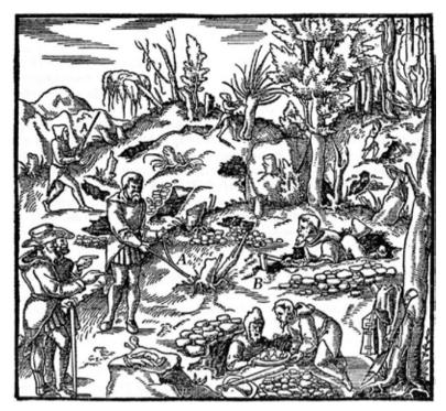
Fig. 1. Ore prospecting by Agricola (1556). A – dowsing rod, B – prospecting trench Ryc. 1. Poszukiwanie złoża rudy według Agricola (1556). A – różdżka, B – rów poszukiwawczy
