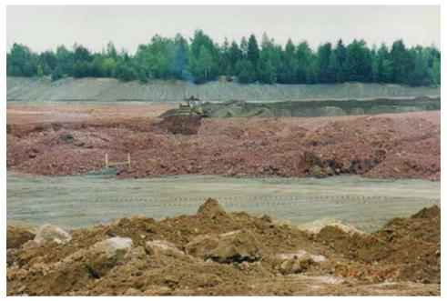
Fig. 15. Reclamation of an open-pit performed by backfilling with flotation tailings, 2002 (photo B. Włodarz) Ryc. 15. Rekultywacja odkrywki górniczej przez zasypanie odpadami poflotacyjnymi, rok 2002 (fot. B. Włodarz)
