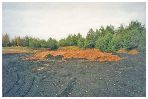
Fig. 14. Reclamation of an open-pit performed by backfilling with slags, 2002 (photo B. Włodarz) Ryc. 14. Rekultywacja odkrywki górniczej przez zasypanie żużlami pokutniczymi, rok 2002 (fot. B. Włodarz)
