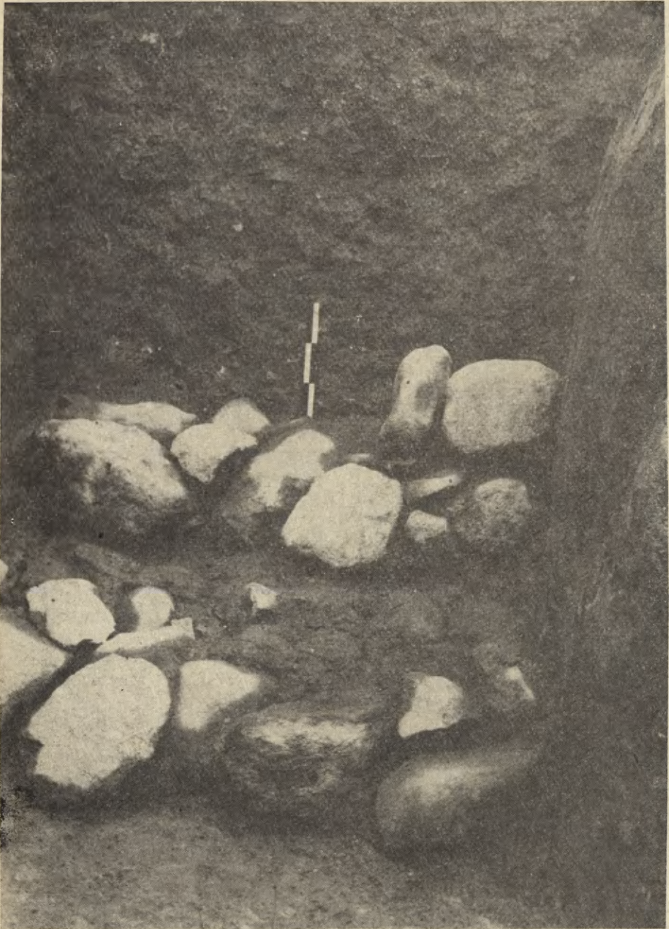
Ryc. 3. Płock, Wzgórze Tumskie. Stopa fundamentowa rotundy
