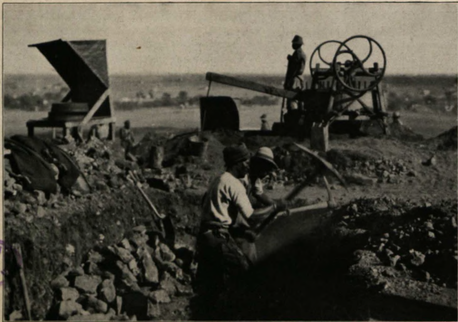
Zuerst wird der „gravel“; der diamanthaltige Grund, losgebrochen.
