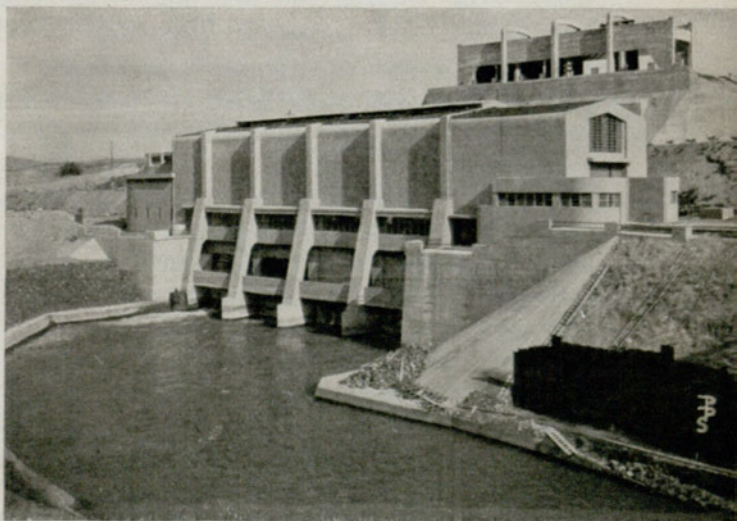
Das Kraftwerk der Palestine Electric Corporation [Rutenberg-Gesellschaft] an der Stelle des Jarmuk - Wasserfalls, 1932
