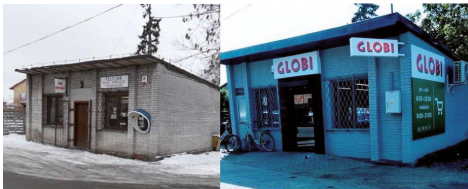
Fot. 1. Sklep wiejski zaadaptowany przez sieć Carrefour (fot. B. Gosik) Village store adapted by Globi (owned by Carrefour)
