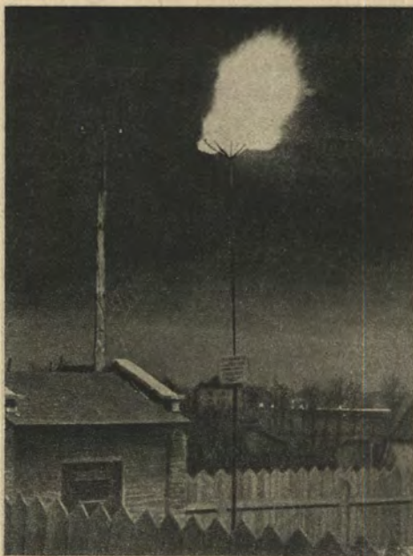
Rurociąg gazu ziemnego Lwów—Stryj. Zdjęcie przedstawia pokaz wybuchu.
