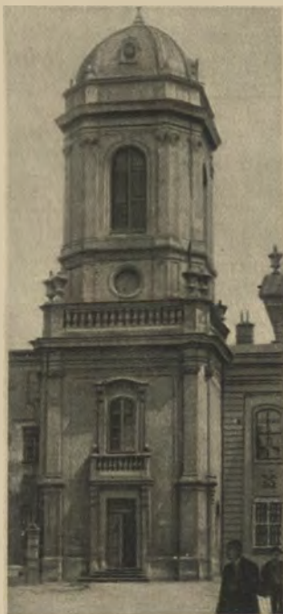
Wieża boczna Dominikanów.
