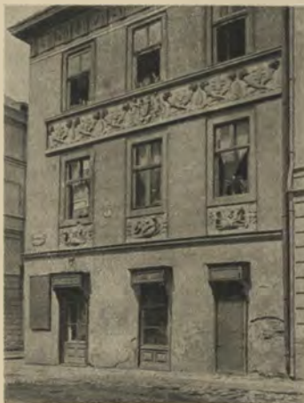
Dom empirowy przy ul. Szarbkowskiej.
