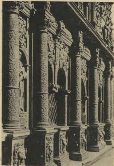
Kaplica Boimów, portal.
