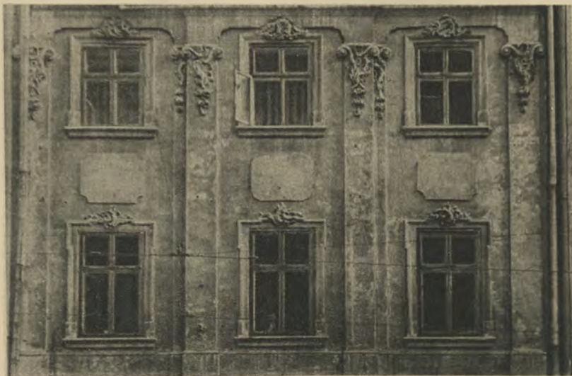
Fragment kamienicy przy ul. Ormiańskiej.
