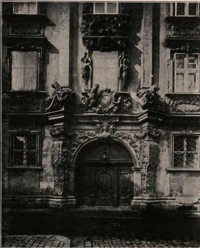
Abb. 44. Hauptportal des Presshauses in Bamberg.
