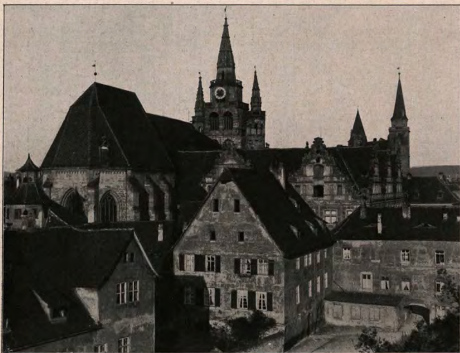
Abb. 97. St. Gumbertus- und St. Johanniskirche zu Ansbach. Nach einer Photographie des Oberleutnants Freiherrn von Wendland in Ansbach. (Zu Seite 158.)
