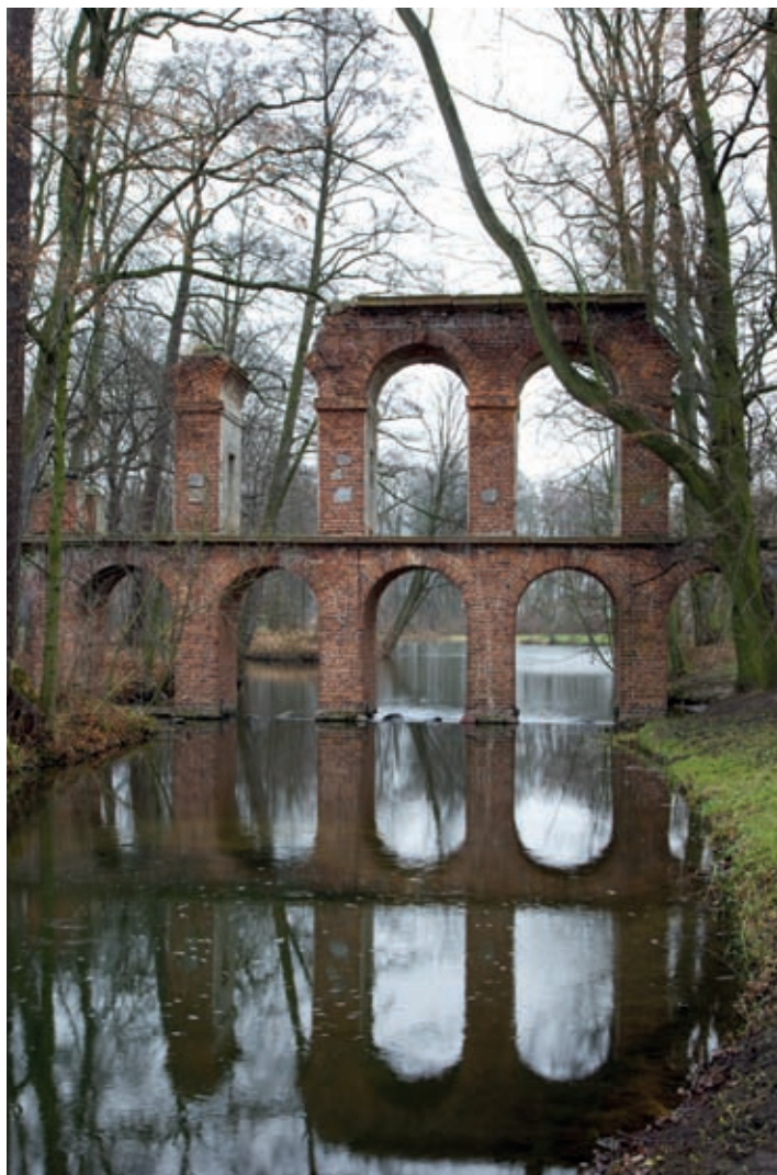
Fig. 22. “Aqueduct” in Arcadia near Nieborów. Photo: M. Bogacki
