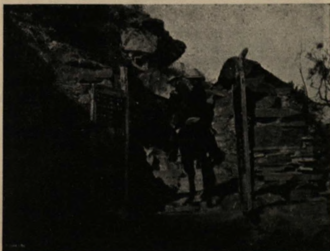
Wjazd na Mésa de los Cartujanos.
